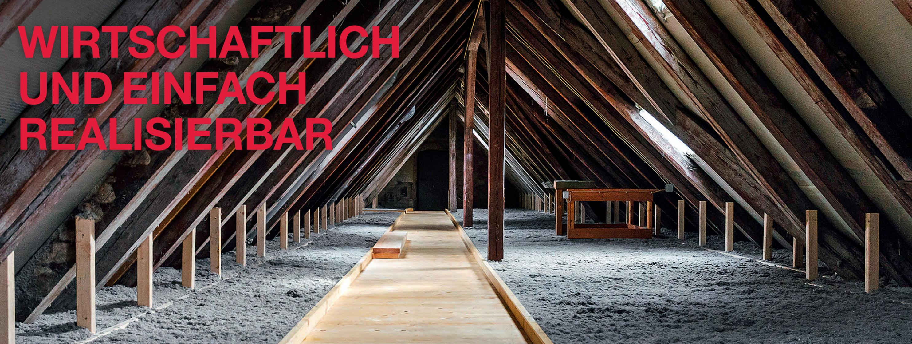
Als ungedämmte Decke im obersten Geschoss gilt nach DIN 4108-2 (Ausgabe 02.2013) ein U-Wert von  $\geq 0,91 \text{ W}/(\text{m}^2 \cdot \text{K})$ . Betondecken ohne zusätzliche Dämmschichten und Konstruktionen von Holzbalkendecken gelten dementsprechend als „ungedämmt“. Sie fallen unter die EnEV-Nachrüstpflicht: Der geforderte U-Wert nach der Dämmmaßnahme beträgt  $\leq 0,24 \text{ W}/(\text{m}^2 \cdot \text{K})$ .
